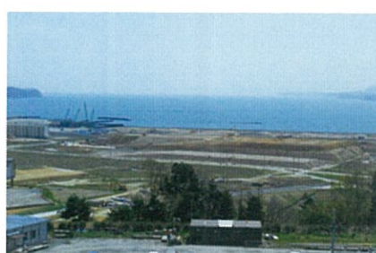
盛土工事が進む市街地
